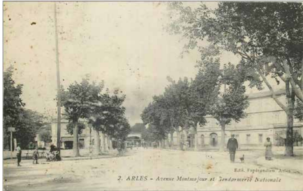
La Route de Fontvieille devient l'Avenue de Montmajour. Sur la droite de la carte postale on voit l'Hôtel de gendarmerie construit en 1870. La Place Lamartine en cours d'urbanisation. Les tracés routiers sont bien défini les voies présentes des front bâtis plus ou moins continus.
