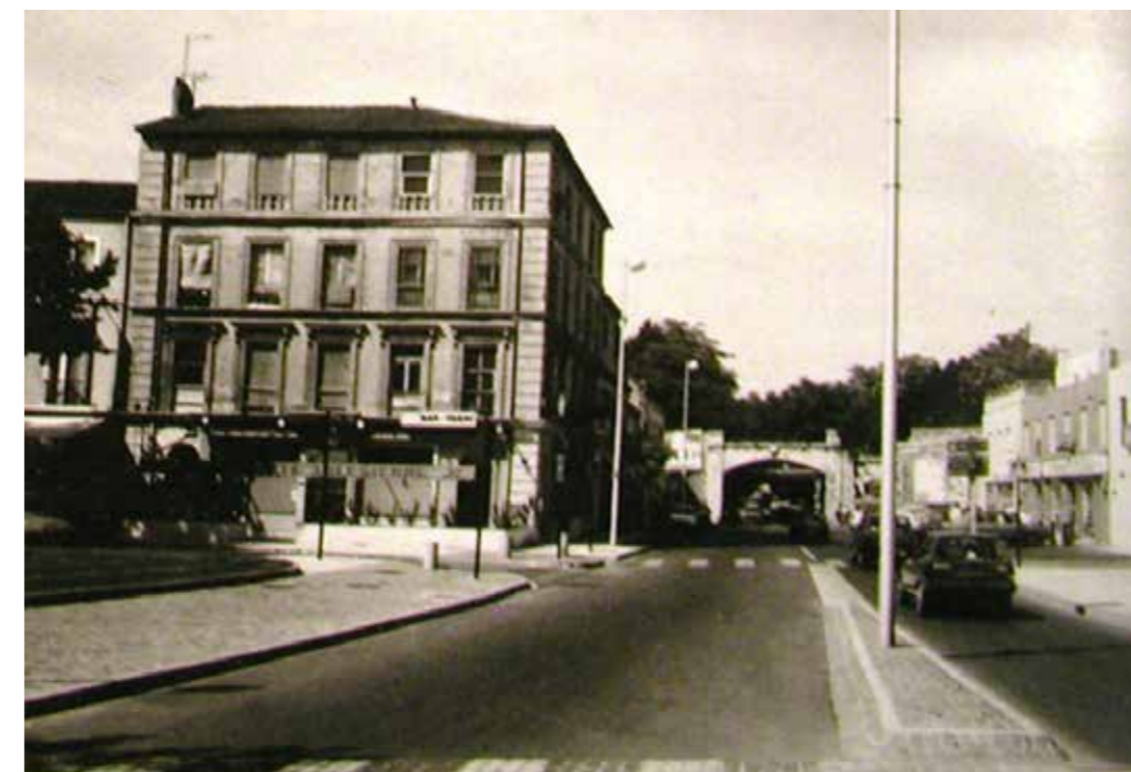
La Maison Jaune a disparu suite à la reconstruction des années 1950. La municipalité Camion a procédé à de nouvelles interventions sur la Place Lamartine. En résulte un projet minéral dont le principal usager est la voiture.
