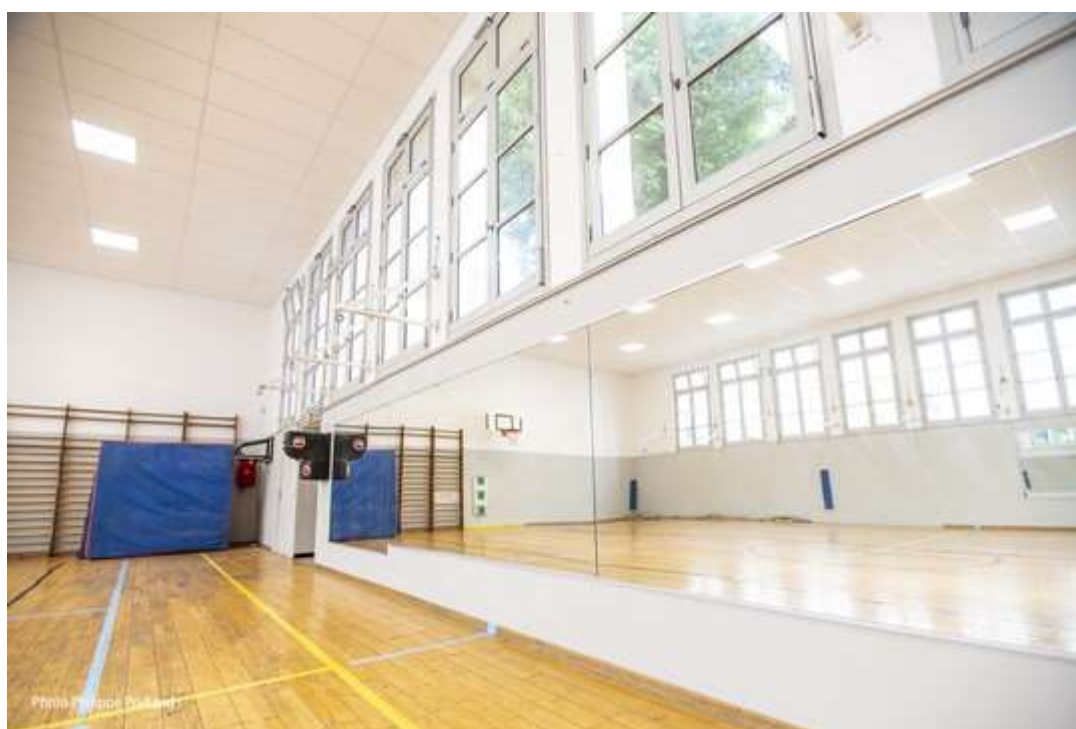
Remplacement menuiseries au gymnase Amédée Pichot (2023).
