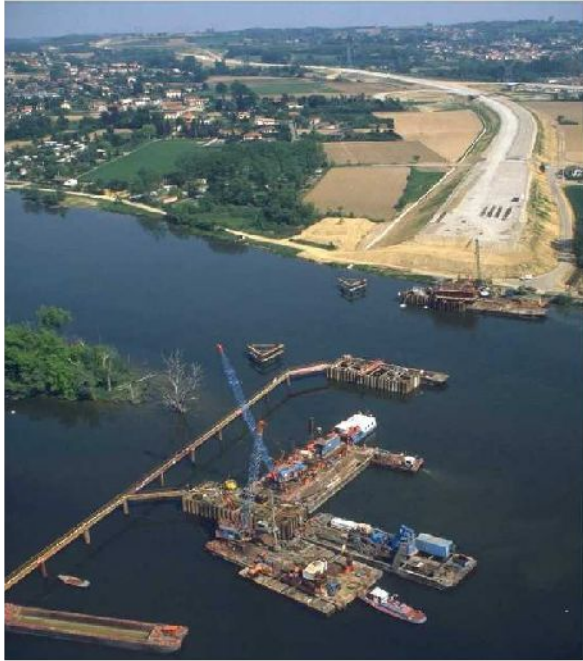
Figure 10 Exemple des travaux de fondations du viaduc de la Saône
