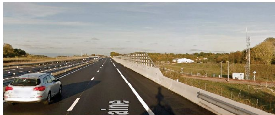
Figure 7 : Exemple d'écran anti-déversement pour le franchissement de la LGV SEA par l'A10 à hauteur de Fontaine-le-Compte – source : image street-view
