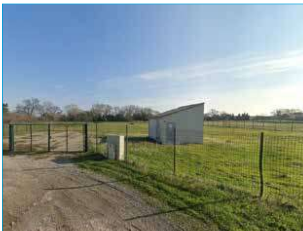
Captage d'eau et son périmètre de protection immédiat (enclos) à Saint-Martin-de-Crau
