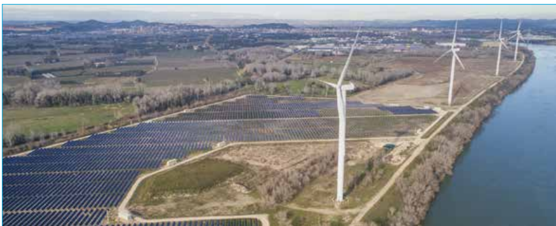
Le secteur au nord de la centrale photovoltaïque doit être aménagé jusqu'au pont
