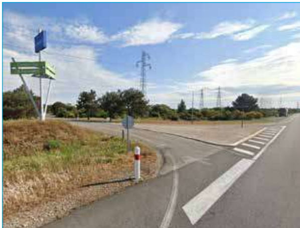
Couloir de lignes le long de la RD268
