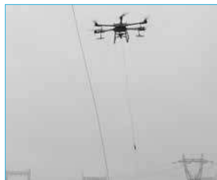
Déroulage de conducteurs par drone
