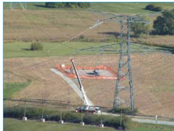
Plateforme de déroulage aménagée au niveau de certains pylônes
