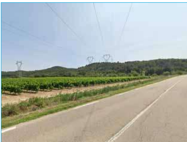
Couloir de lignes au nord de Beaucaire
