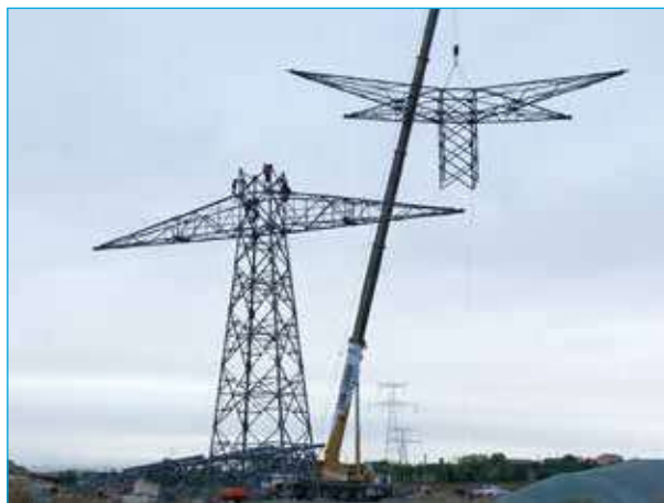
Montage d'un pylône
