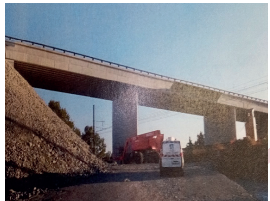
Contrôle IQOA «Image de la qualité des ouvrages d'art», pont de désenclavement du port fluvial à Arles Nord
