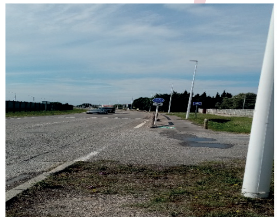
Maintenance éclairage public
