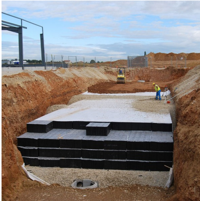
Bassin de rétention alvéolaire proposé : Modèle NIDAPLAST
