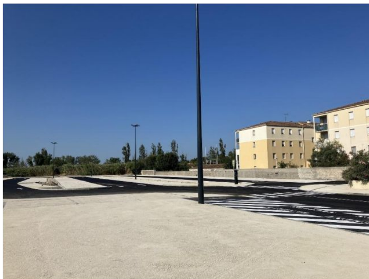
Parking P4 (ancienne caserne des pompiers)
