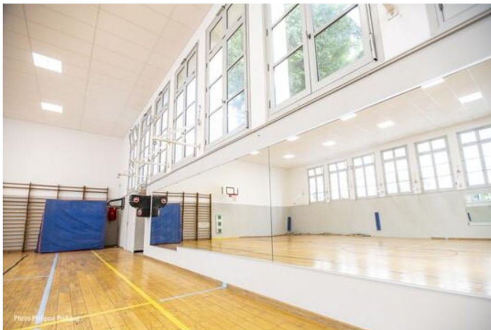
Remplacement menuiseries au gymnase Amédée Pichot (2023).
