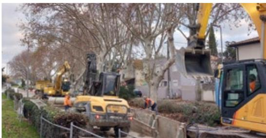
Travaux de renouvellement des réseaux d'assainissement secteur Bariol-Vissac - ©ACCM
